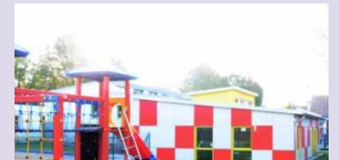
Ausbau Kindergarten Giebelstadt
