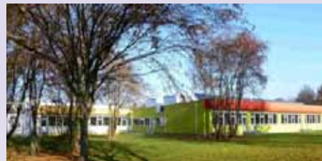
Ausbau Schule Giebelstadt
